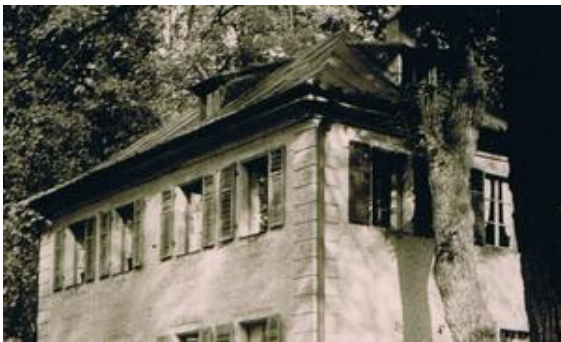
Die Villa Boin in den 60er-Jahren: Aus der Terrasse wächst ein Baum. Im Dach befinden sich noch die originalen Dachgauben. Foto: Boin
